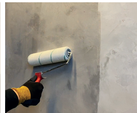
9. Försegla ytan med Sikafloor®-169 PT för en blank yta eller Sikafloor®-304 W för en matt yta. Försegling utförs alltid i minst två lager. Mjukfogar utförs med SCHÖNOX ES Transparent (Blank) eller Casco ClearSeal (Matt) .
