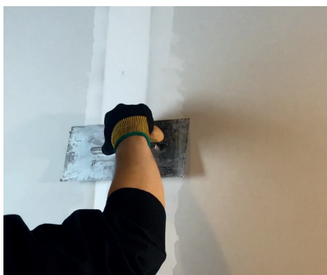
2. Spackla skarvar och skruvhål med Casco WallCraft .
